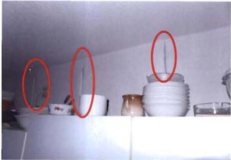
Dekorationsschäden durch eindringende Feuchtigkeit
